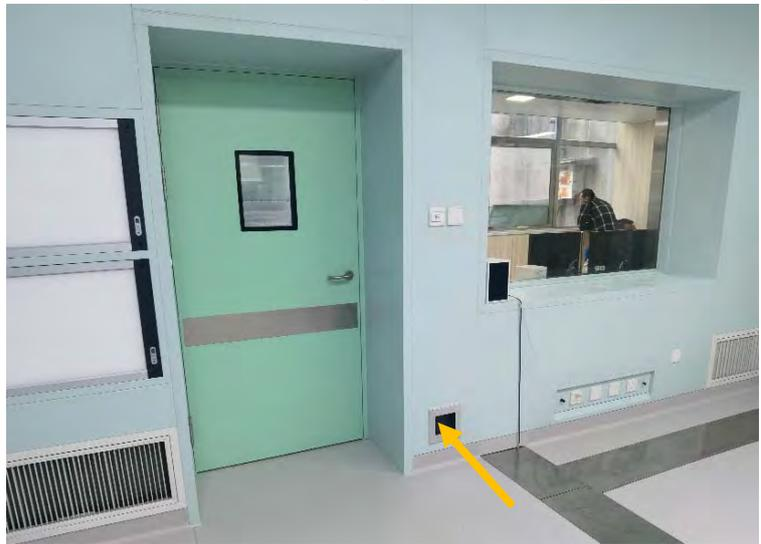
导管 1 室门控开关
