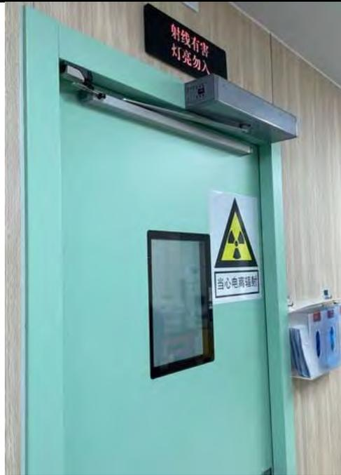
导管 2 室控制室门外的放射性标志、中文警示说明和“射线有害 灯亮勿入”工作状态灯箱
