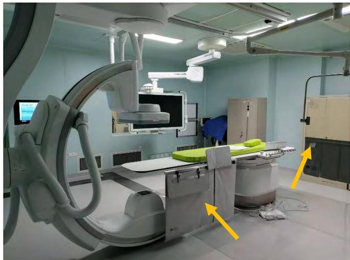
导管 2 室床侧防护帘和铅悬挂防护屏
