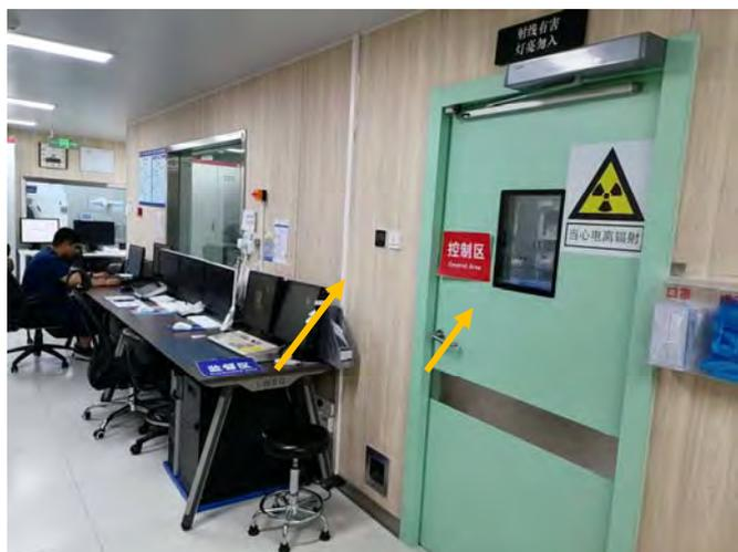
导管 1 室控制室防护门分区标识、电离辐射标志、工作状态指示灯
