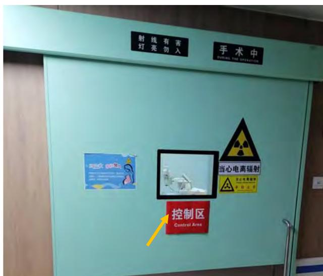
导管 1 室患者防护门分区标识、电离辐射标志、工作状态指示灯
